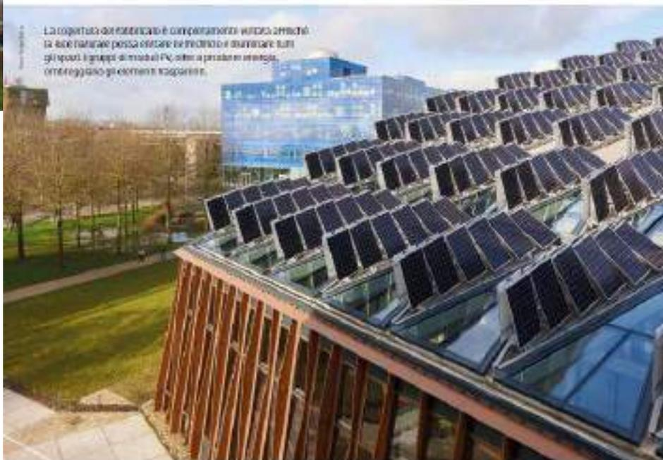
La copertura del fabbricato è completamente vetrata e rivestita in legno. La facciata esterna possiede la funzione di illuminare tutti gli spazi. I gruppi di moduli PV, oltre a produrre energia, ombreggiano gli elementi trasparenti.
